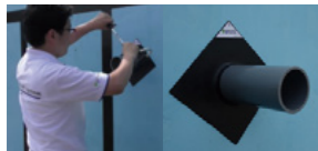
気密部材の施工事例
